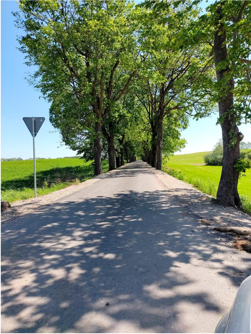
Miejscowość Niemsty po realizacji inwestycji
