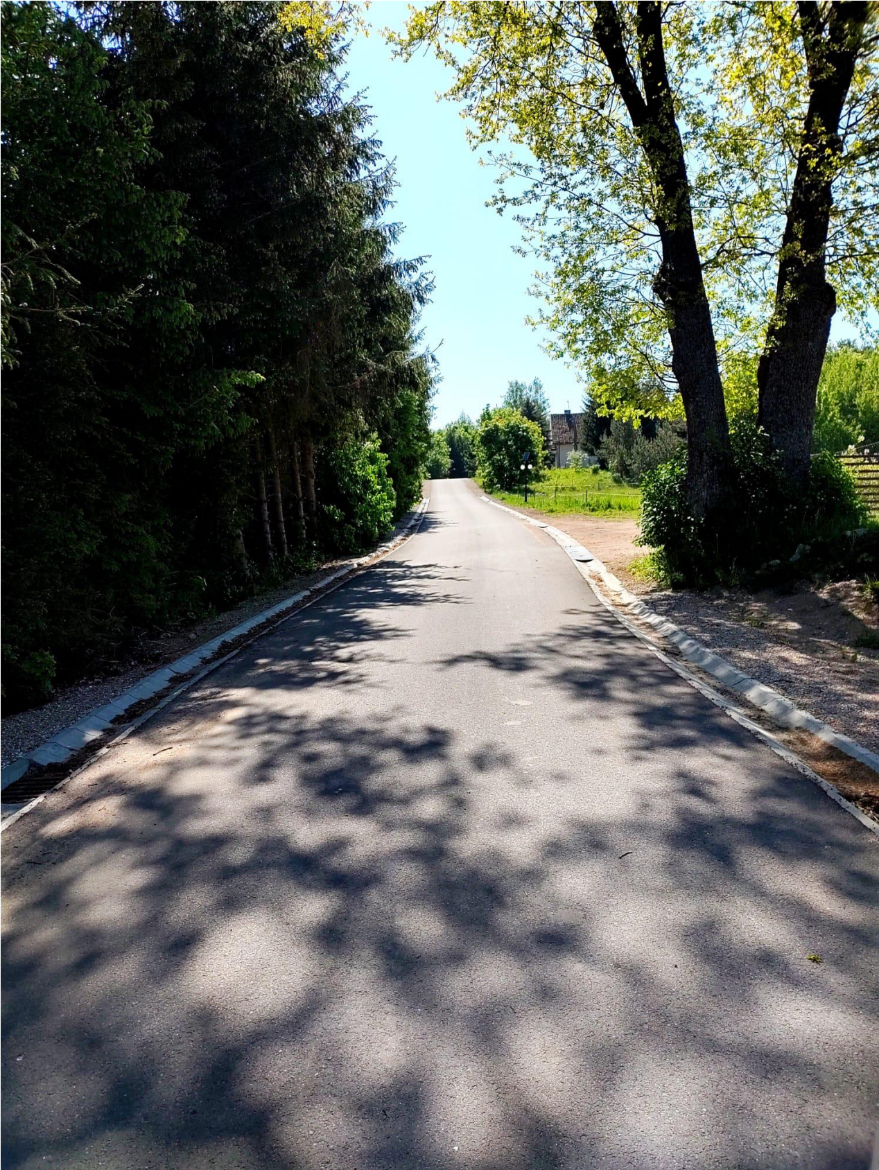
Miejscowość Sulejki po realizacji inwestycji
